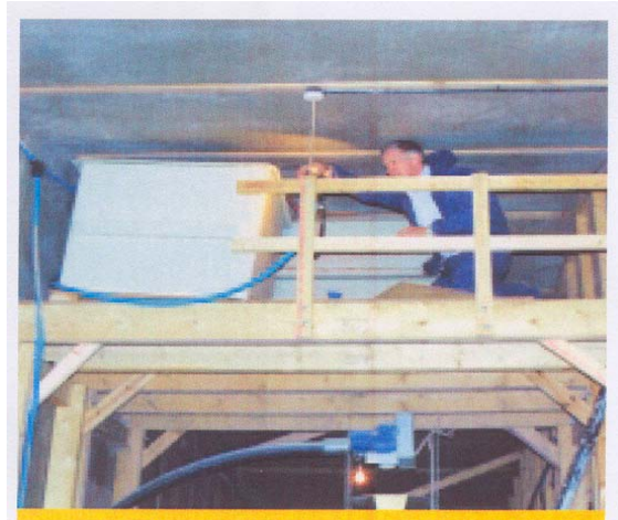
Şekil 11. Su tankında su seviyesinin kontrolü
